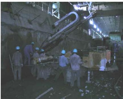
图 15-10a 宝钢某改造项目锚杆施工图
