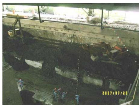
图 15-10b 宝钢某改造项目锚杆板桩基坑开挖图
