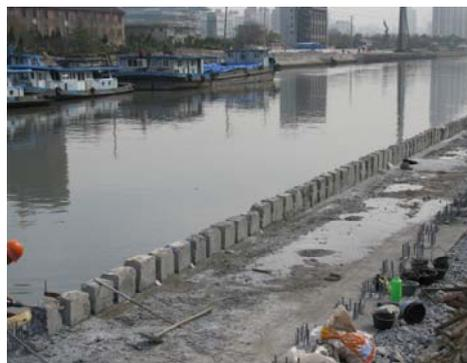
图 15-20b 苏州河防汛墙加固板桩沉后外观图
