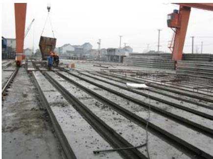
图 15-12a 板桩制作图
