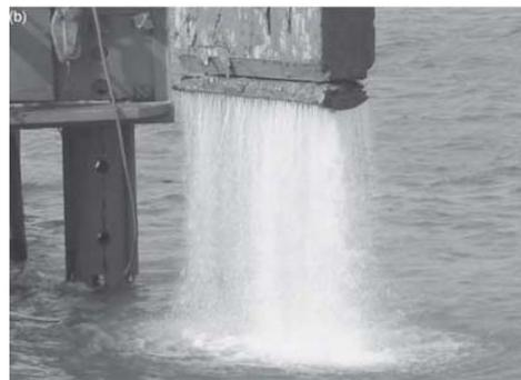
图15-18 板桩射水喷射方法
