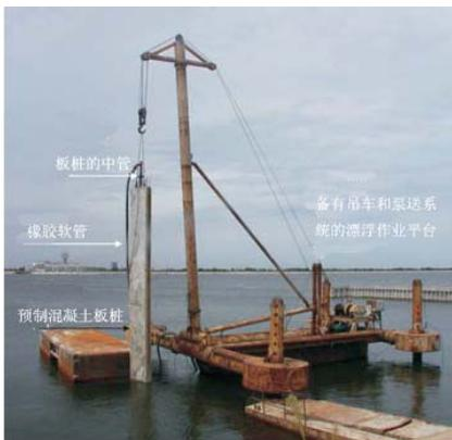
图15-17 预制钢筋混凝土桩插桩
