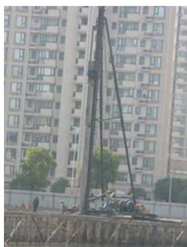
图 15-20a 苏州河防汛墙加固板桩沉桩图
